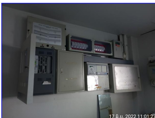
รูปที่ 2.17 Graphic Fire Alarm
