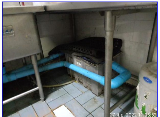
รูปที่ 2.2 ถังพักไขมันใต้อ่างล้างจาน
